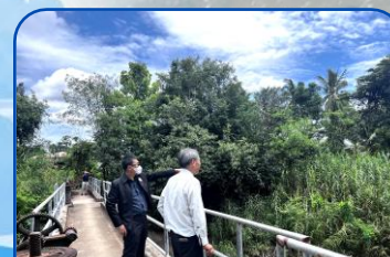
สภาพบริเวณที่ตั้งสถานีสูบน้ำ P5
