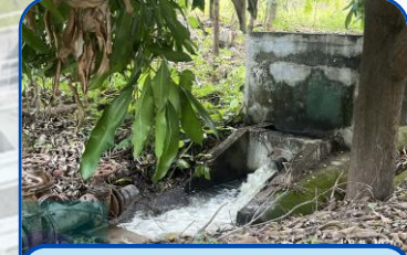
ก่อสร้างคลองห้วยไผ่
