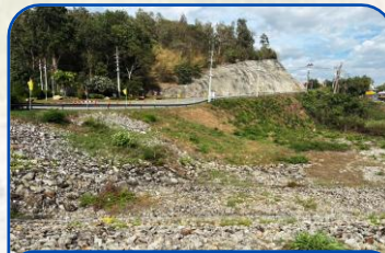
ตำแหน่งที่ตั้งสถานีไฟฟ้าย่อย
